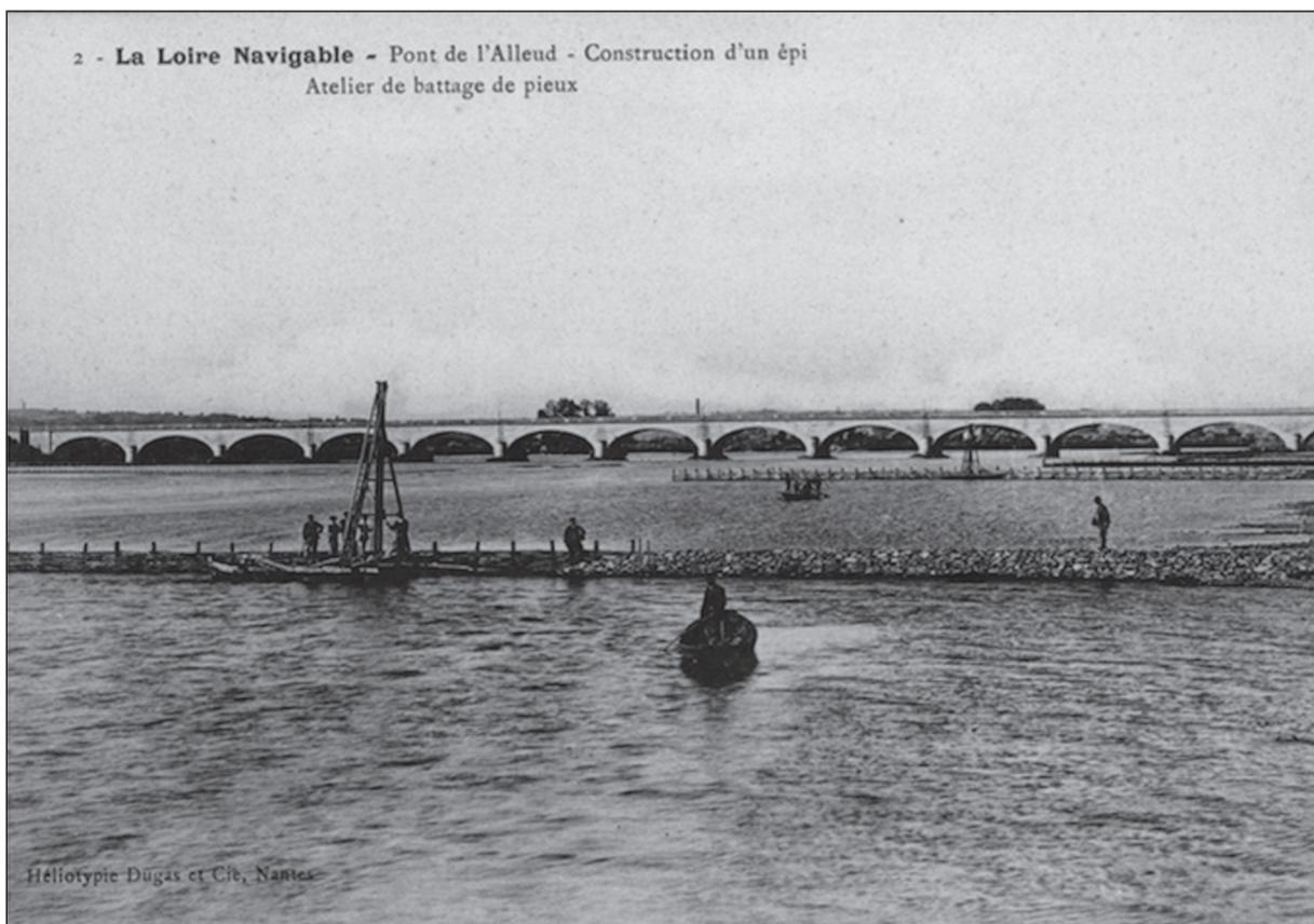
Figure 10. Chantier de construction d'un épi
